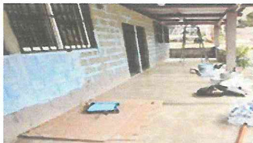
Foto 4: Pintado de paredes
