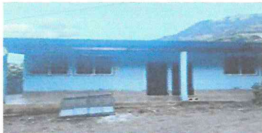
Foto 5: Instalacion de ventanas en PVC
