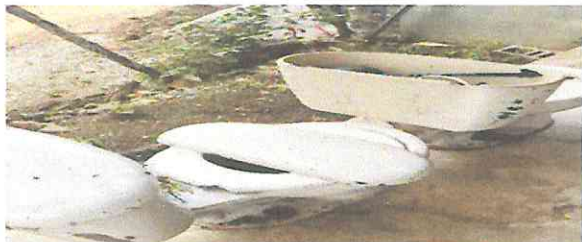
Foto1: Sustitucion de inodoro
