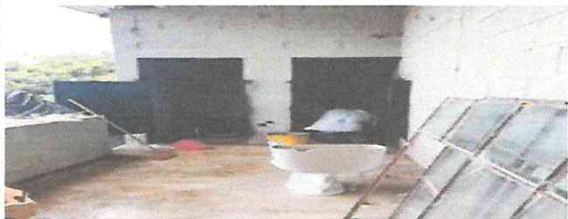
Foto 2: Mantenimiento de puertas de metal en sanitarios
