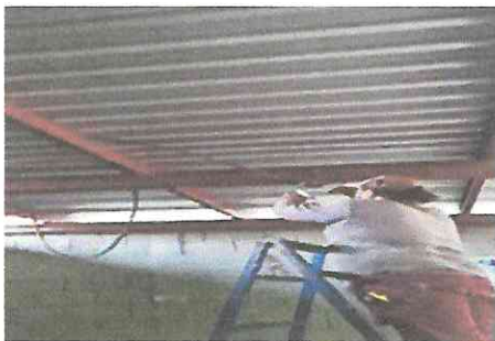
Foto 3: Sustitucion de lamina por lamina troquelada cal 26
